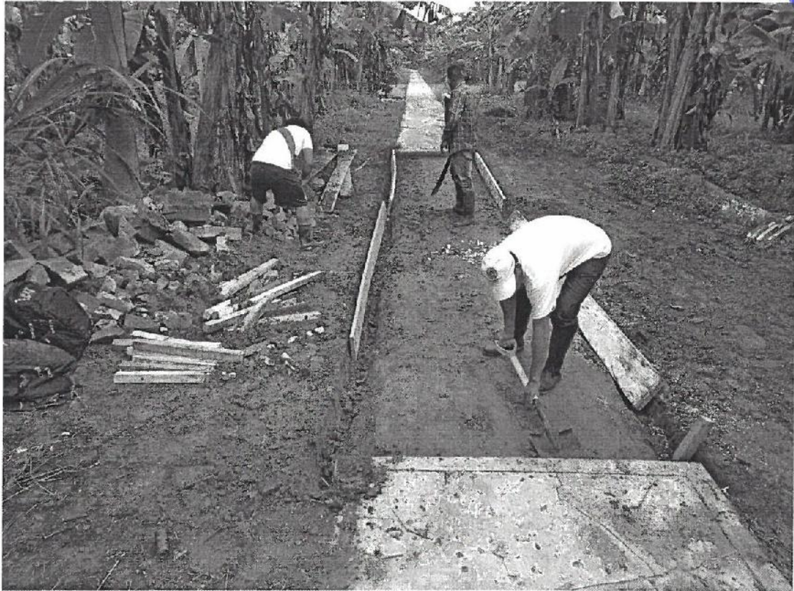
Encofrado de veredas
