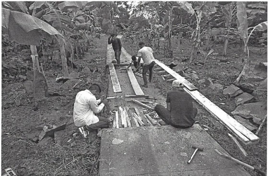
Encofrado de veredas
