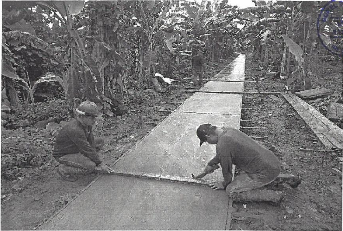
Reglado polvoreado con cemento puro y Bruñado en vereda
