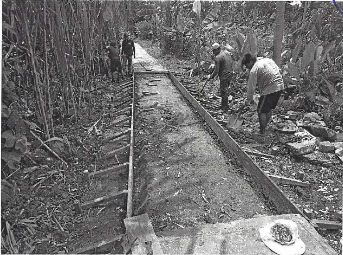
Encofrado de veredas y cama de arena
