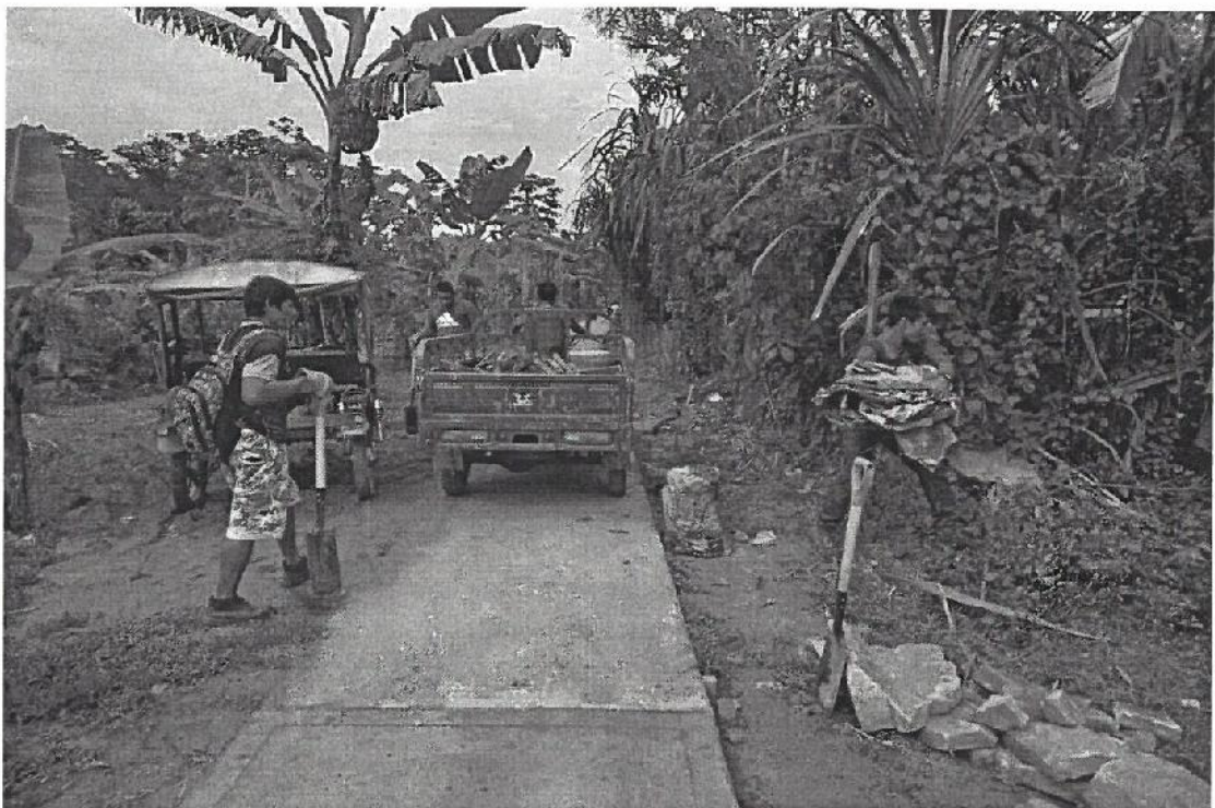
Relleno con asfalto las juntas de dilatación y limpieza en tramos
