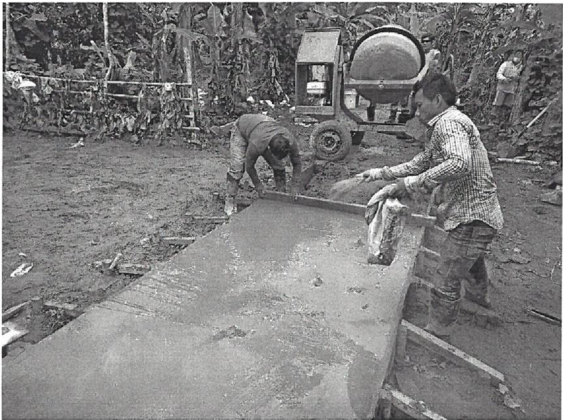
Reglado polvoreado con cemento puro y Bruñado en vereda
