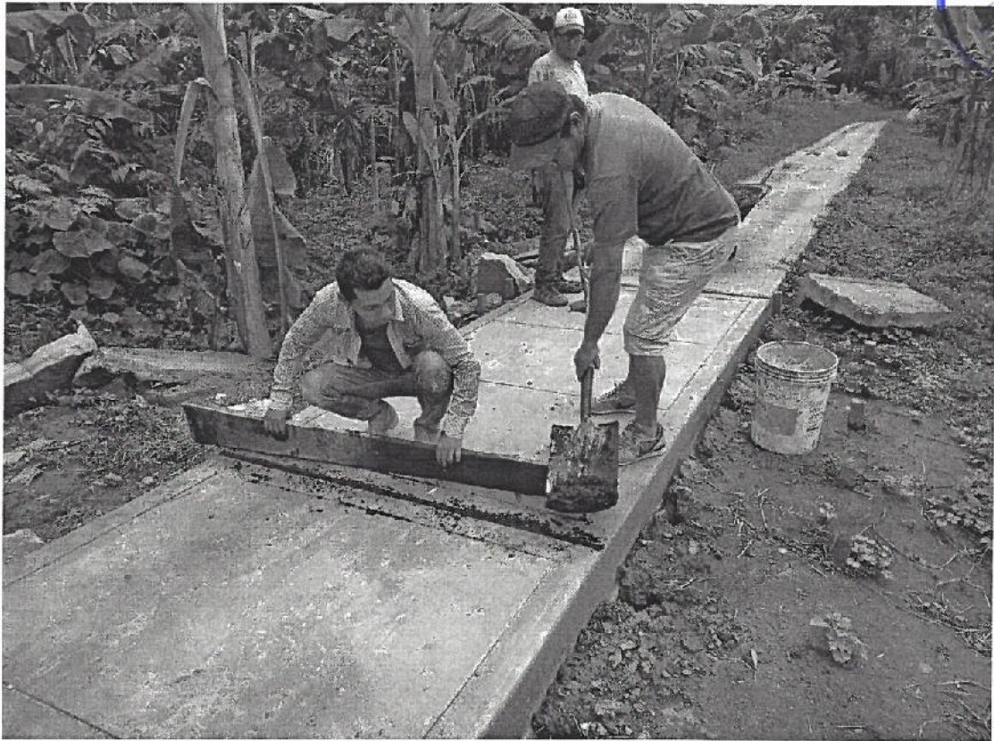
Relleno con asfalto las juntas de dilatación y limpieza en tramos
